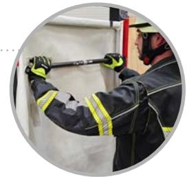
Ansatzpunkte zum Setzen eines Rauchschutzvorhanges.
